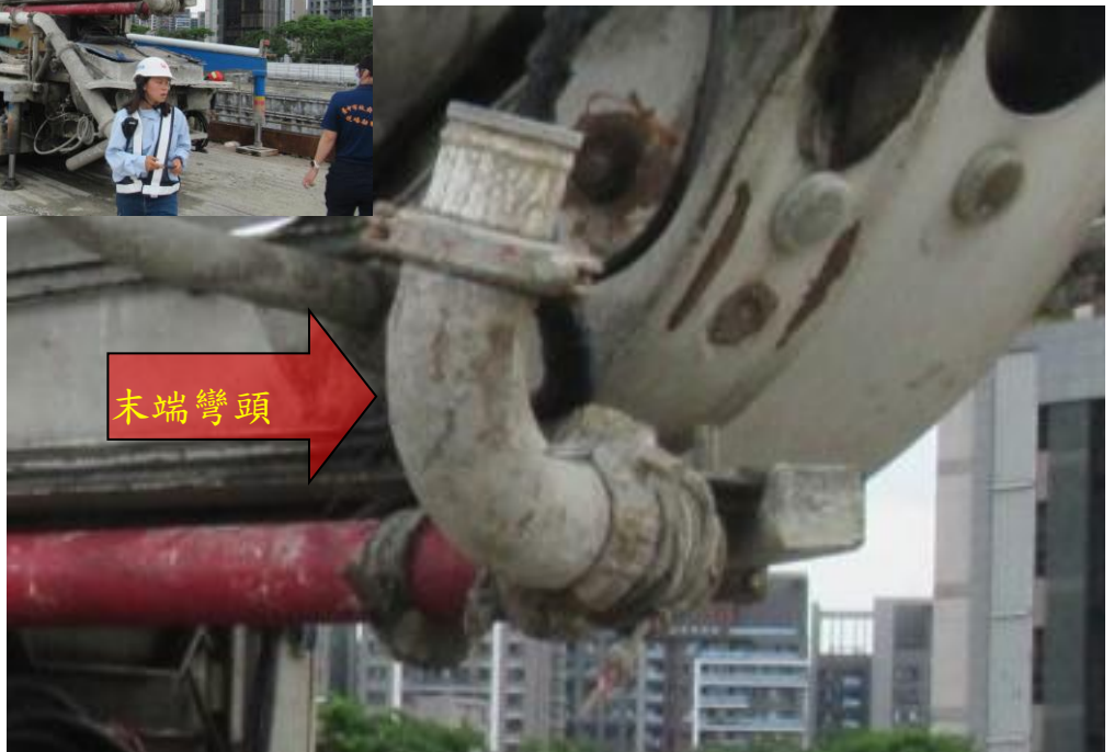
附照4-房○榮稱述太空包固定於混凝土泵浦車壓送管末端彎頭吊運(未發現彎頭斷裂)
