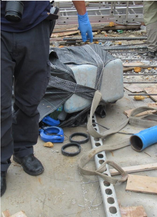
附照3-環眼吊帶穿過太空包吊耳(未發現吊帶或吊耳斷裂)、蘇○承安全帽破裂掉落太空包旁
