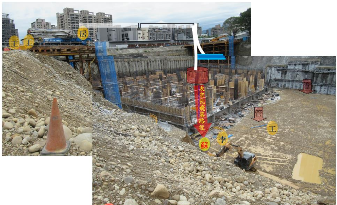
附照2-人員位置圖(房○榮於構台操作混凝土泵送車、罹災者蘇○承於C區地下3層、目擊者李○璐在旁並稱述太空包吊運至C區上方高約8.5公尺處飛落)
