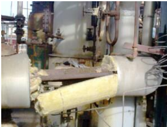
(管線保溫層覆蓋下嚴重腐蝕後洩漏)
