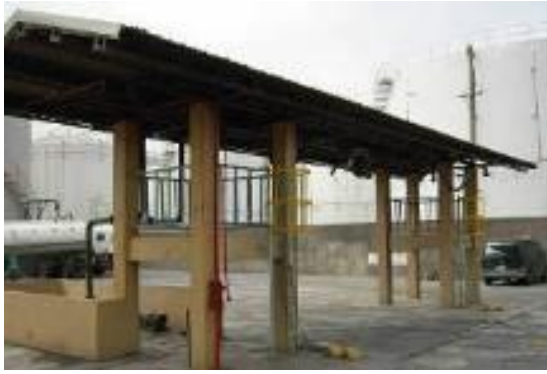
裝卸料站保持乾淨
