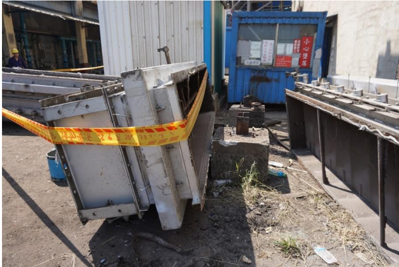
照片 1 風門擋板平放置於墩柱上
