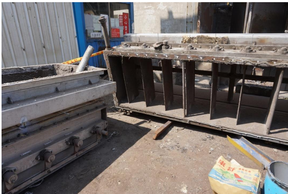
照片 2 進行風門擋板連桿切割作業發生風門擋板倒塌致死
