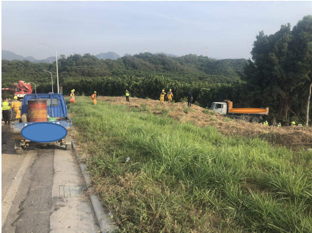
說明 2 | 車輛卡於邊坡林間方停止滑動。
